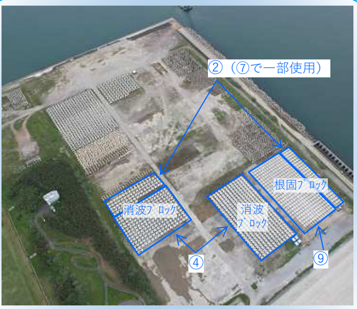
高砂・仮置きヤード
