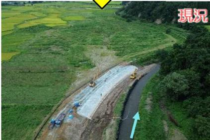
護岸ブロック設置（堤防復旧中）
