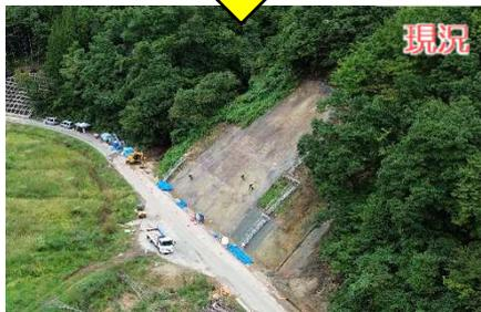
土砂撤去、法枠設置（斜面復旧中）
