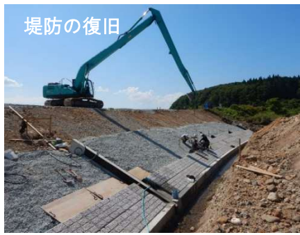
施工中の法岸工
