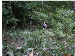
緩衝林帯整備のための除伐・下刈り
