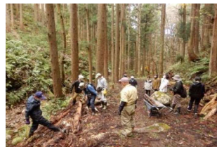
古道上の支障木等除去作業
