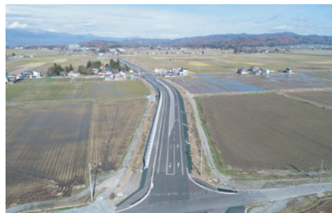
かわにし (国)287号「川西バイパスエ区(I期区間)」(川西町)[R6.3.9開通]
