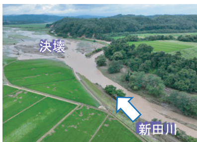
一級河川新田川 堤防決壊状況
