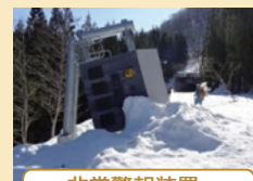
非常警報装置・ 通信設備の修繕
