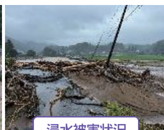
浸水被害状況
