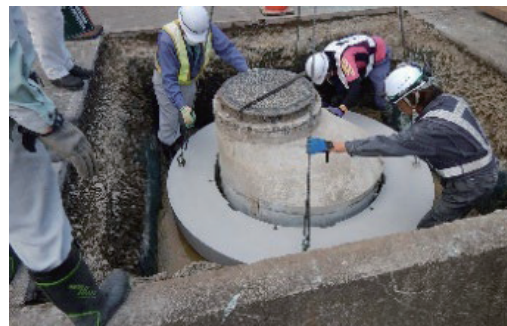
管路施設の耐震化工事「ハットリング工法」 (マンホール浮き上がり防止)
