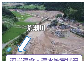
河岸浸食・浸水被害状況
