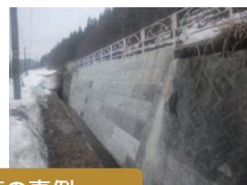
斜面崩壊対策の事例
